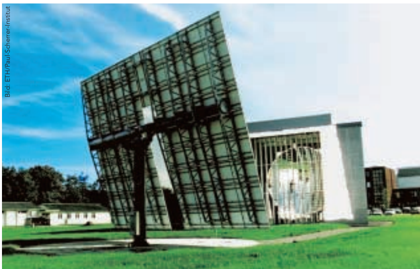
Mittels Solaranlagen testet das PSI chemische Prozesse in Hochtemperatur-Solarreaktoren.
